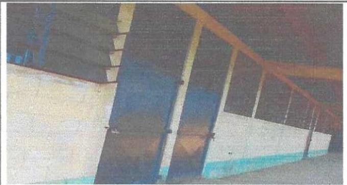
Foto 6: Se observa el deterioro de la pared. Se necesita sustitución de repello y cernido de pared.
