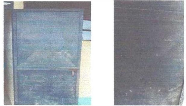
Foto 4: Se observa el deterioro de las puertas. Se necesita sustitución de puertas.
