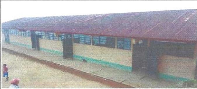
Foto 1: Se observa el deterioro del entechado. Se requiere sustitución.
