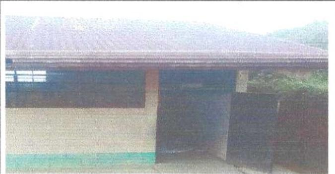
Foto 2: Se observa del deterioro de canales y bajada de agua pluvial. Se requiere sustitución de canales y bajada de agua.
