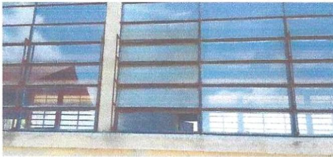
Foto 5 Se observa el area del ventanado piezas de vidrio en mal estado. Se requiere sustitución.
