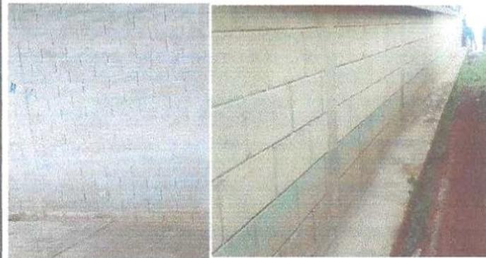
Foto 3: Se observa el deterioro de pintura. Se necesita sustitución de pintura
